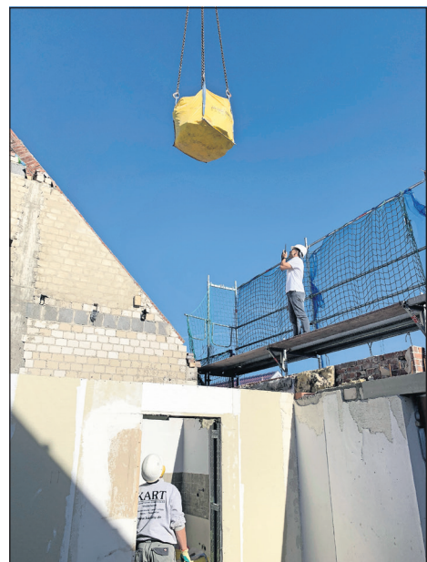
Der Bauschutt wurde in Säcken aus dem Gebäude gehoben.
