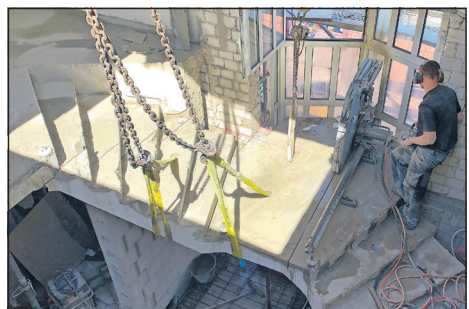
Für die Demontage einer Treppe kam eine leistungsstarke Wandsäge zum Einsatz.
