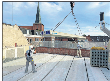
Im Obergeschoss des Sparkassengebäudes wurde eine neue Decke verlegt. (Foto: Aydin Kart)
